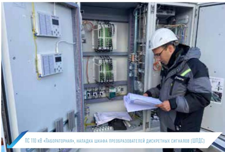
ПС 110 кВ «Лабораторная», наладка шкафа преобразователей дискретных сигналов (ШПДС)
